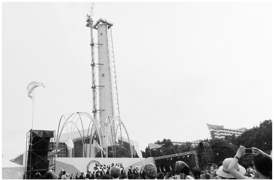
工事中の光が丘清掃工場（エントツが短くなっている）
